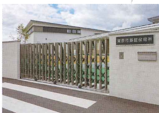
築館保育所・築館幼稚園／宮城県栗原市
