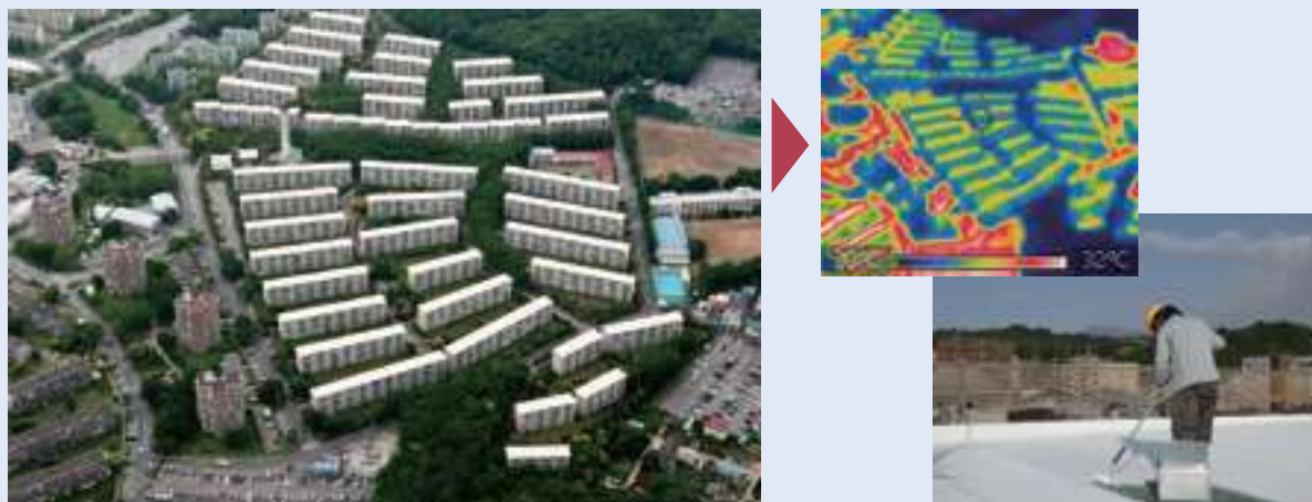
【サーモコントロール断熱で防水改修した建物屋根表面温度】(サーモグラフィカメラにて撮影:2012年6月16日外気温22.2℃)
