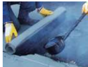
溶融したアスファルトを用いた防水の施工
