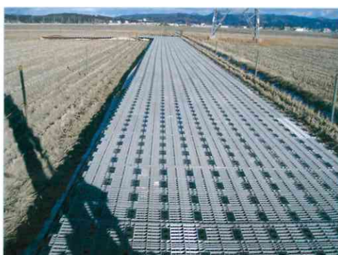
②スペーサーを敷設
