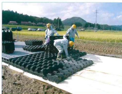
①プラロードを敷設
