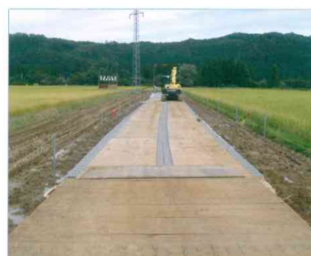
③上面に鉄板を敷設
